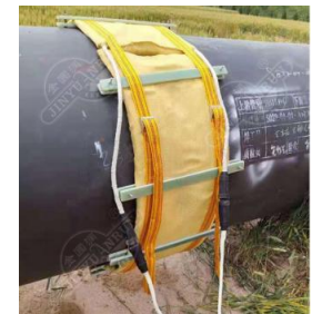
便携式油气管道焊接和涂敷预热设备
